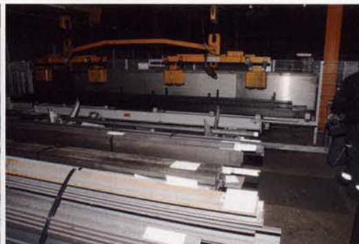
Für die Bündelung am Portal hebt der Magnetkran die Materialien aus den kast-Kassetten.
